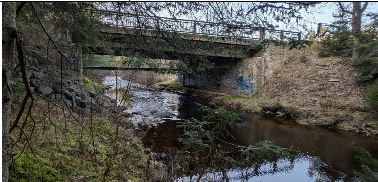
Photo 4. Vue sur le ruisseau Noir sous le pont de la route 327 (1+450).
