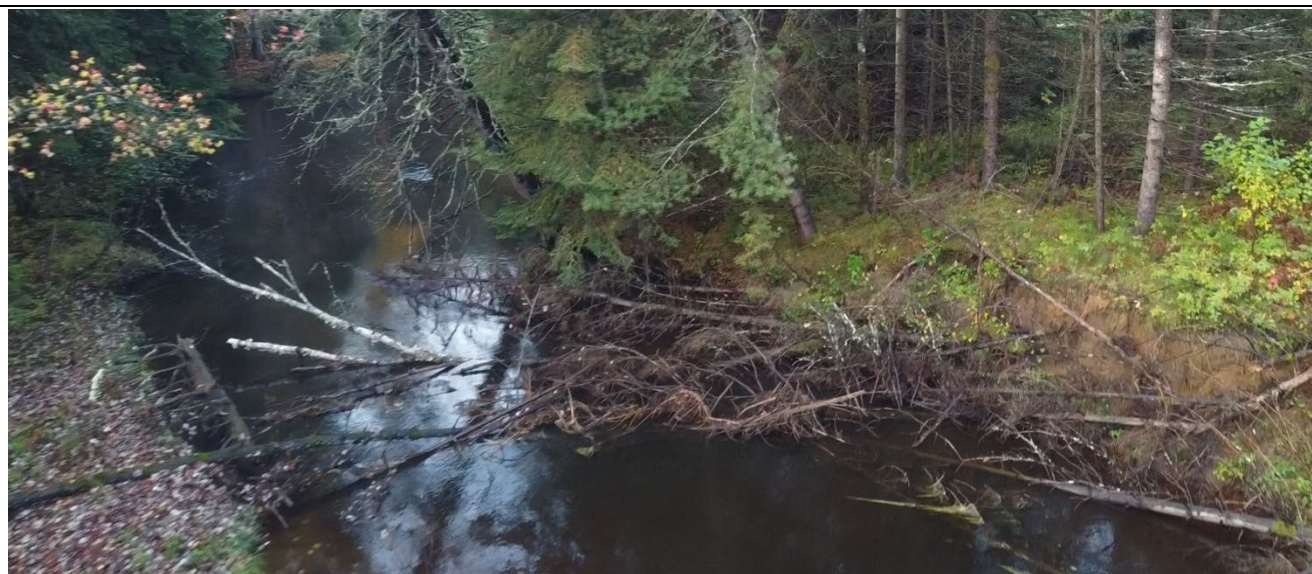
Photo 3. Début d'embâcle de bois juste en aval de la zone d'érosion (1+520).
